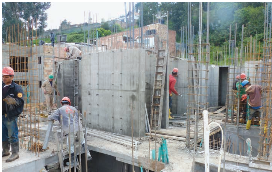
↑ Muros y losas construidos con sistemas industrializados.
